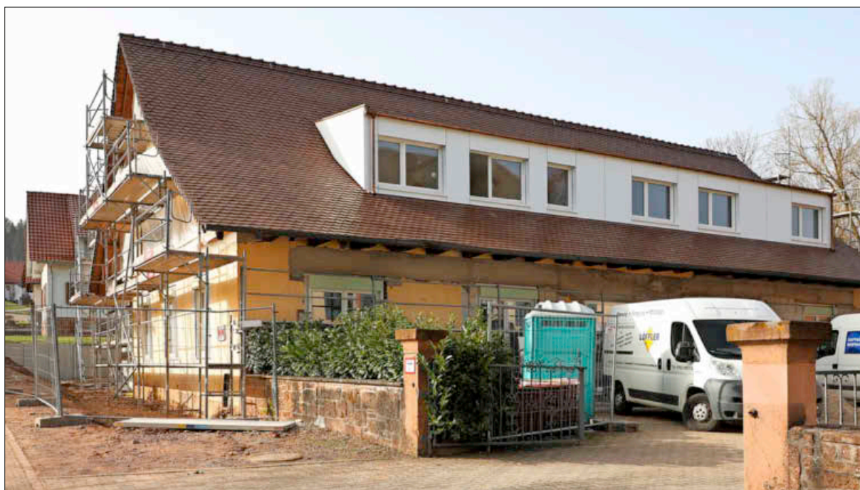
An der Pfarrscheune in Schuttertal wird noch gebaut, währenddessen schreiten die Planungen für den späteren Betrieb fort.
